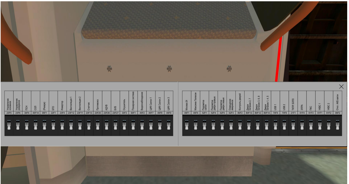
Рисунок 38 – Задний левый торцевой шкаф
